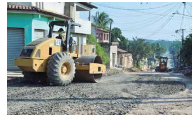
Pavimentação em rua no bairro Aldeia da Prata. Crédito: divulgação
