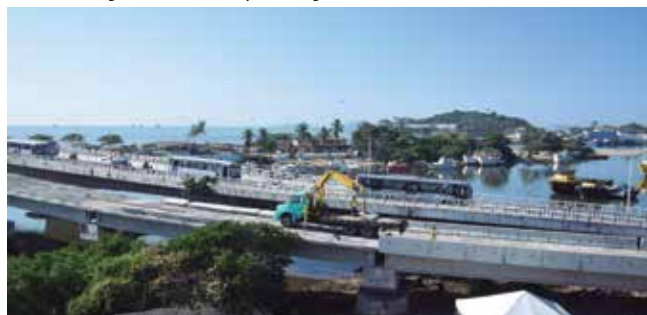
Com nove metros de largura e 280 de comprimento, ponte Ivan Mundim vai ligar o Centro à Barra de Macaé. Crédito: divulgação
