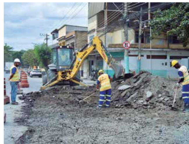
Pavimentação da avenida Zoelo Sola, no bairro Triângulo. Crédito: divulgação
