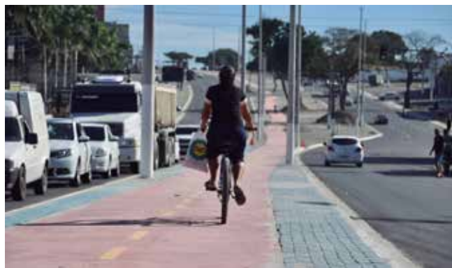
Em Itaboraí, a avenida 22 de Maio recebe obras de drenagem, pavimentação, reurbanização e sinalização viária. Crédito: divulgação
