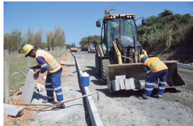
Pavimentação da Estrada da Boa Vista, em São Pedro da Aldeia. Crédito: divulgação
