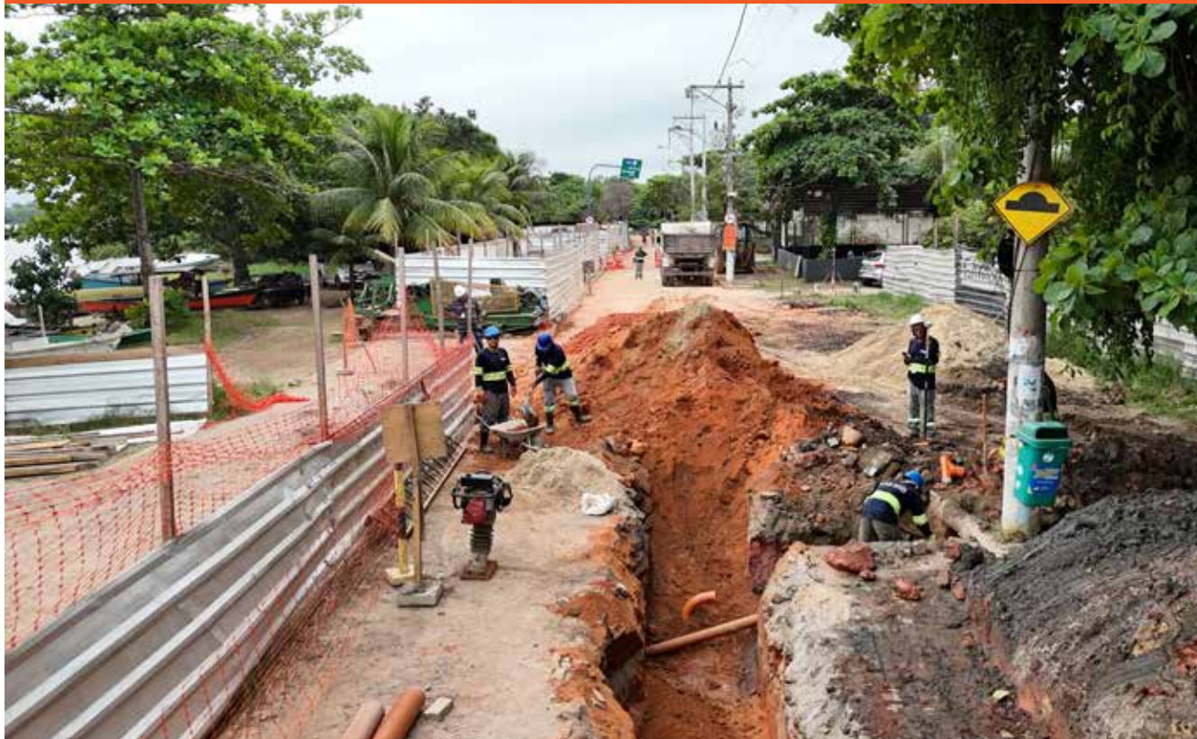
Construção de coletores de esgoto na Praia das Pedrinhas, em São Gonçalo. Crédito: divulgação
