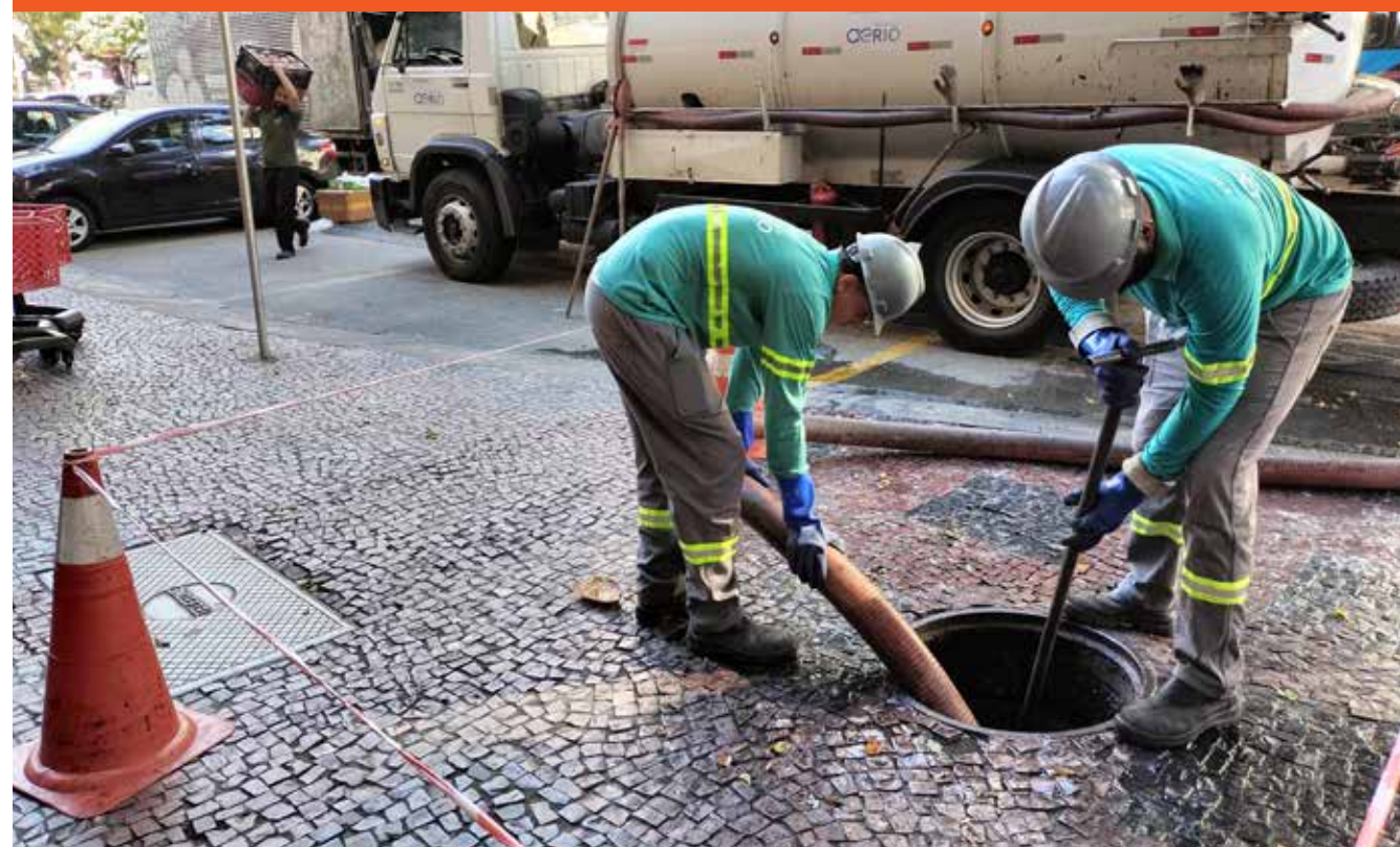
Desobstrução de rede de esgoto no entorno do Rio Maracanã. Crédito: divulgação/Águas do Rio
